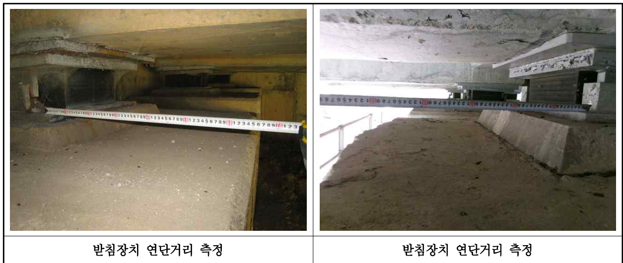
【사진 2.3.14】 교량받침장치 연단거리측정
