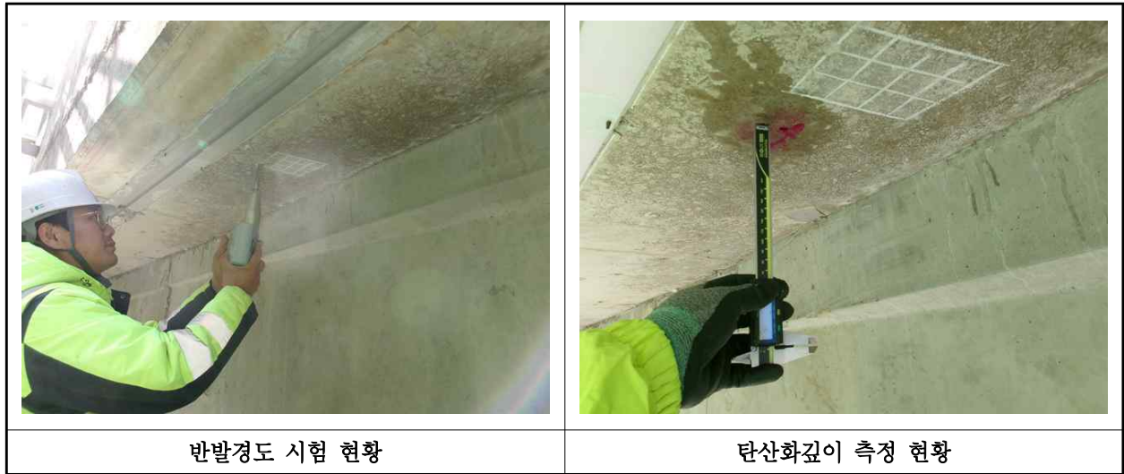
【사진 2.4.1】 콘크리트 내구성조사 현황
