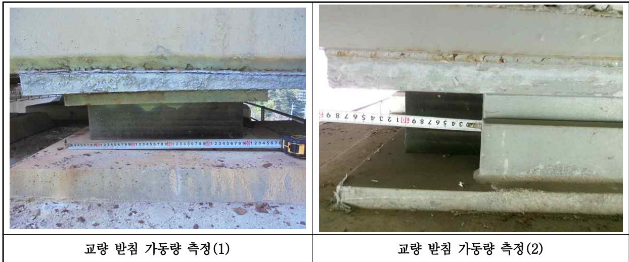
【사진 2.3.15】 교량받침 이동량 측정
