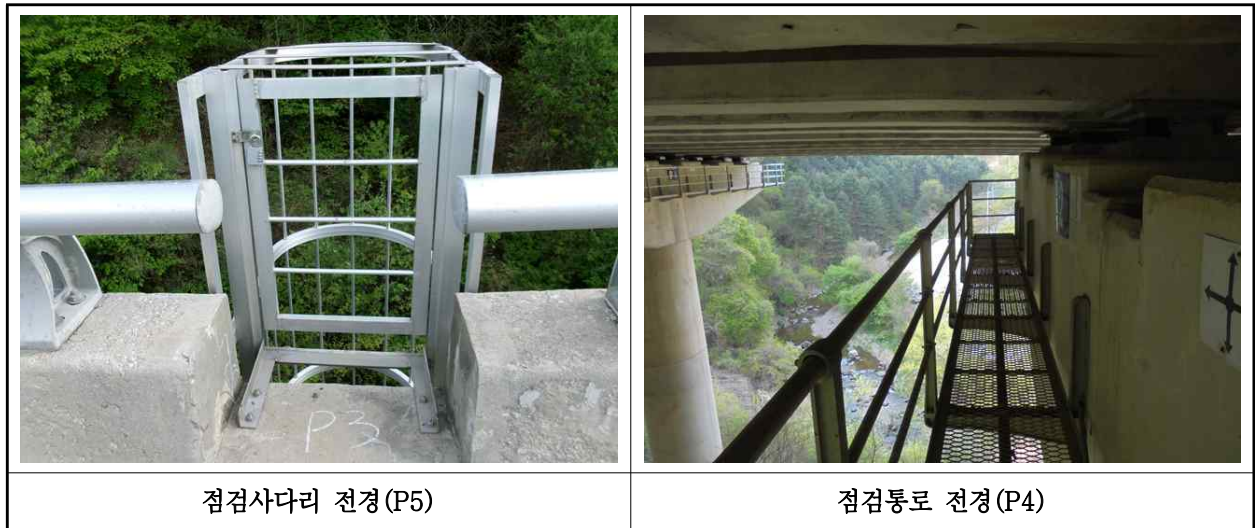
【사진 2.3.25】 교량 점검시설 전경
