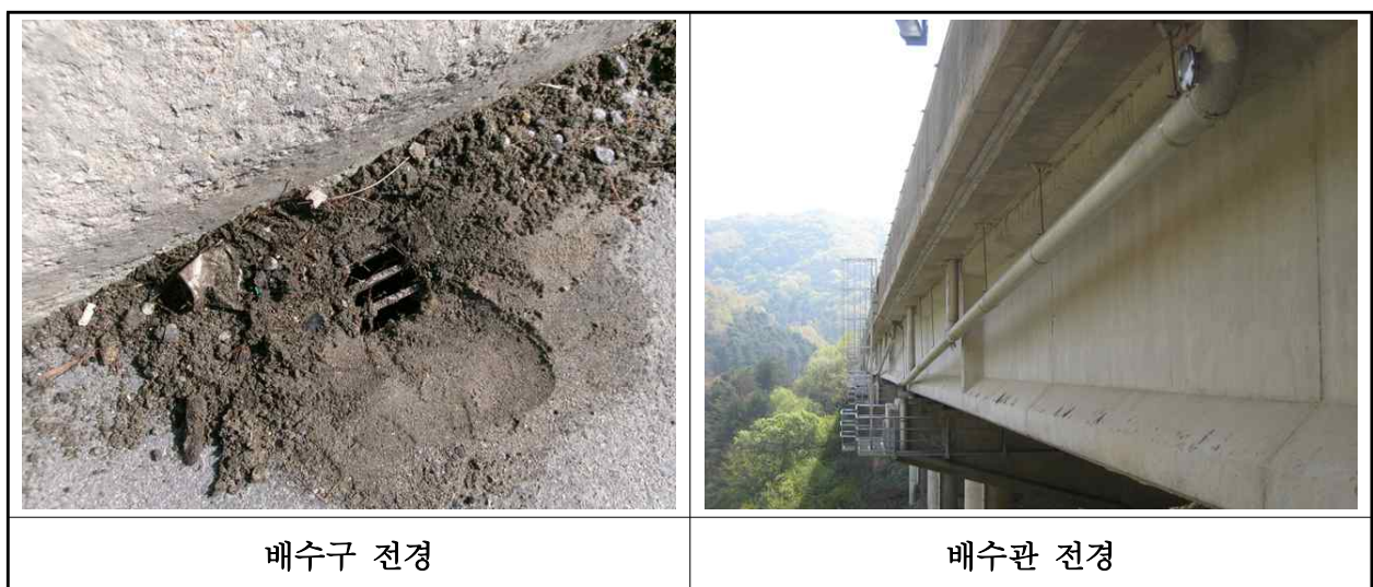
【사진 2.3.21】 배수시설 전경
