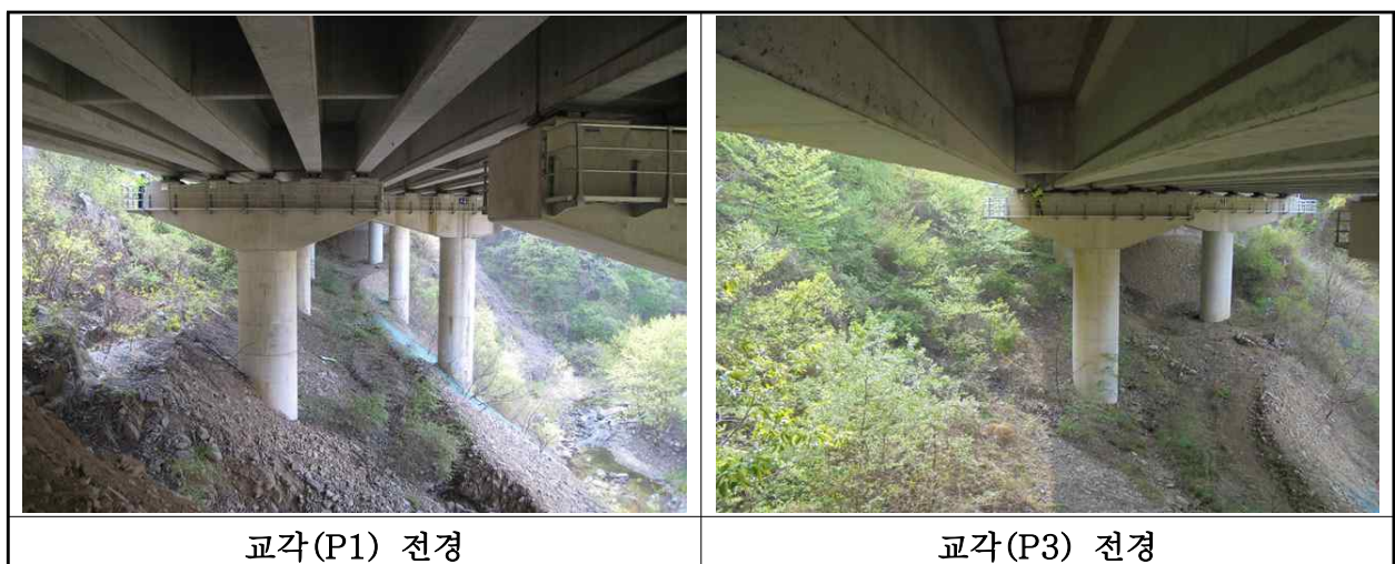
【사진 2.3.10】 교각 전경
